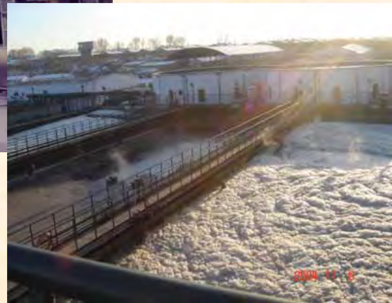
ハルピン製薬工場の廃水処理工事
